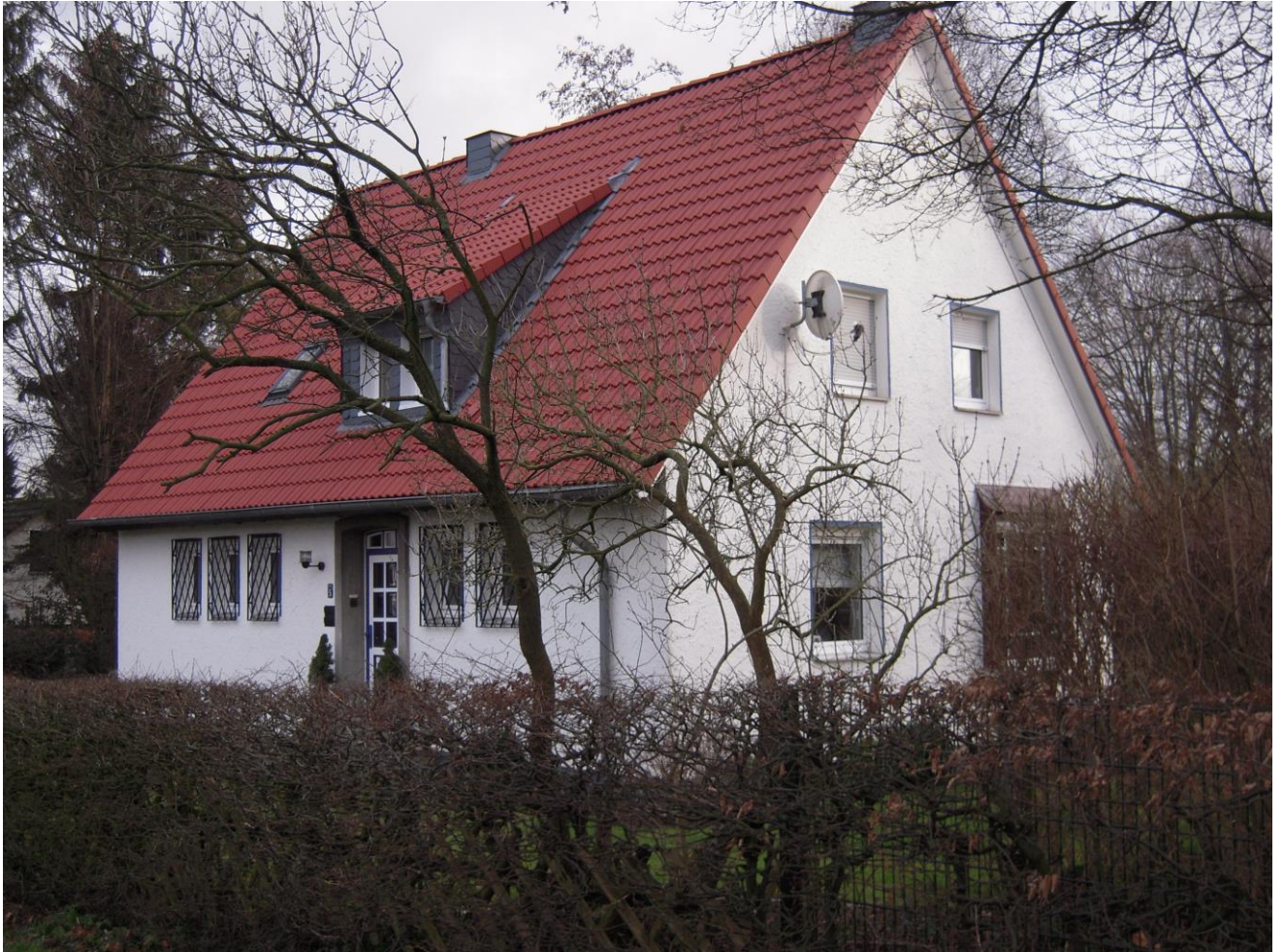
2012, das 1955 errichtete neue Lehrerwohnhaus; Foto: Verf.
