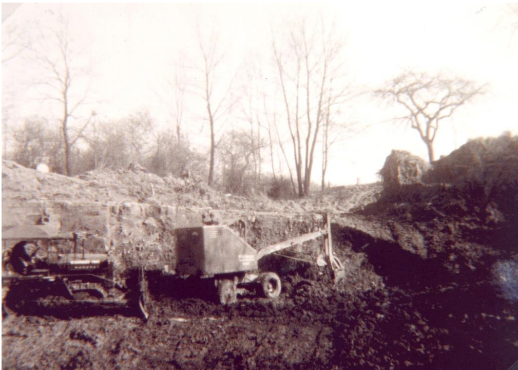
In Linhoff's Steinbruch wird mit schwerem Baugerät gearbeitet; Foto: Album Linhoff
