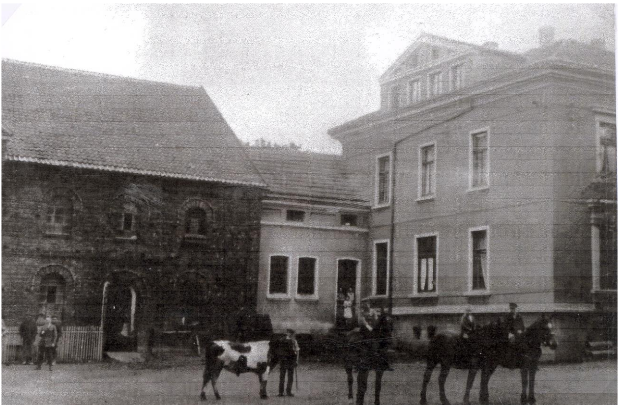
Abb. F9.2: Gut Schulze Oben; von Westen - vermutlich in den 1930er Jahren
