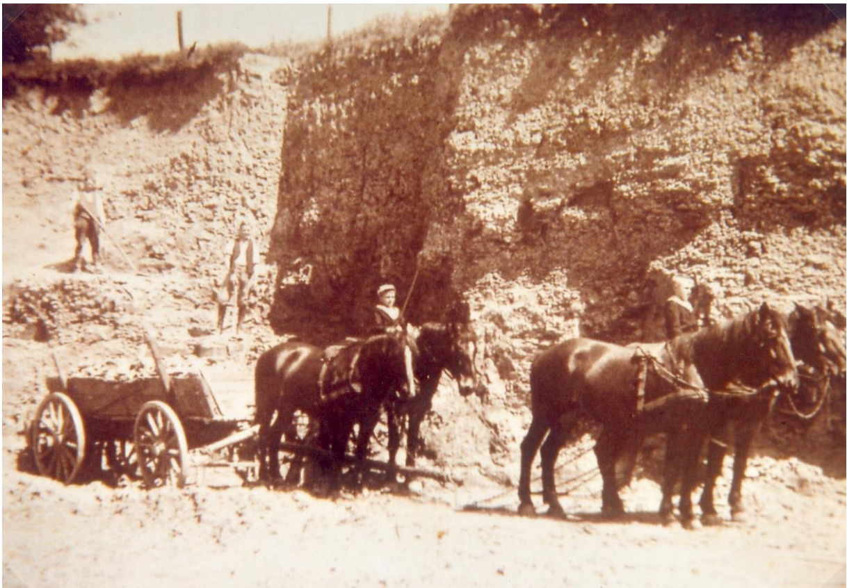
Abb. F18.1: Abräumen von Gesteinsschutt im Haumann'schen Steinbruch; Aufnahme: vermutlich vor dem 1. Weltkrieg, Repro: H. Lange
