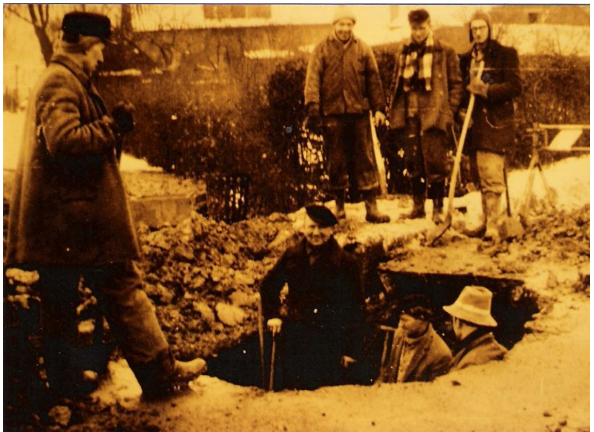
F6.9 Eine Kolonne des Wasserwerks f. d. nördl. westf. Kohlenrevier bei der Behebung eines Rohrbruches (um 1960)
