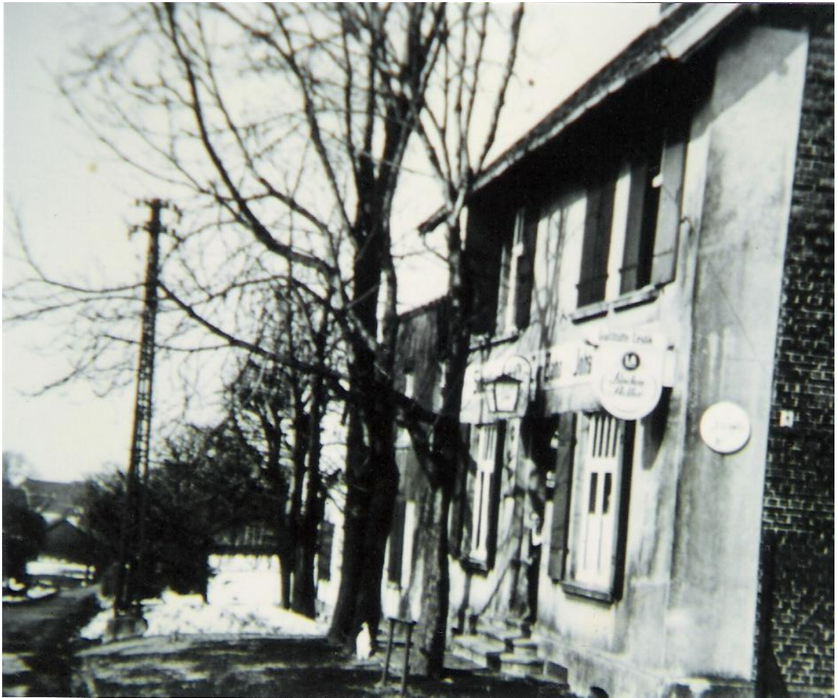
F27.7 Gaststätte Ceslik, Kessebüren 1957, Straßenansicht
