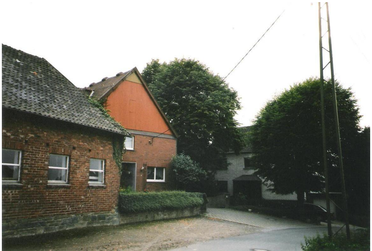
F5.9 Ostbüren, früherer Hof Schröer (links) und früheres Mietshaus des Dampfbäckers Wiemann, Eschweiler
